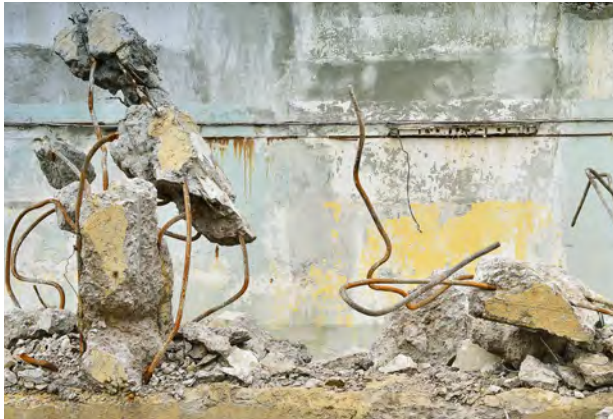
コンクリート解体
