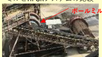
図3 実機既設ボールミル外観
