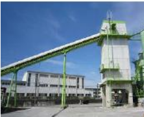
生コンプラント全景
