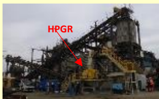
図2 HPGR実機外観
