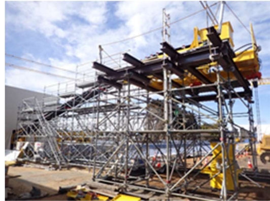
写真④ 仮設資材ヘッド例
