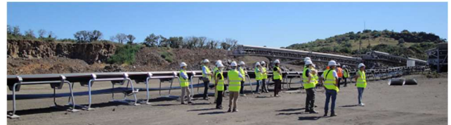
写真-⑧ 仮設ベルトコンベヤ写真
