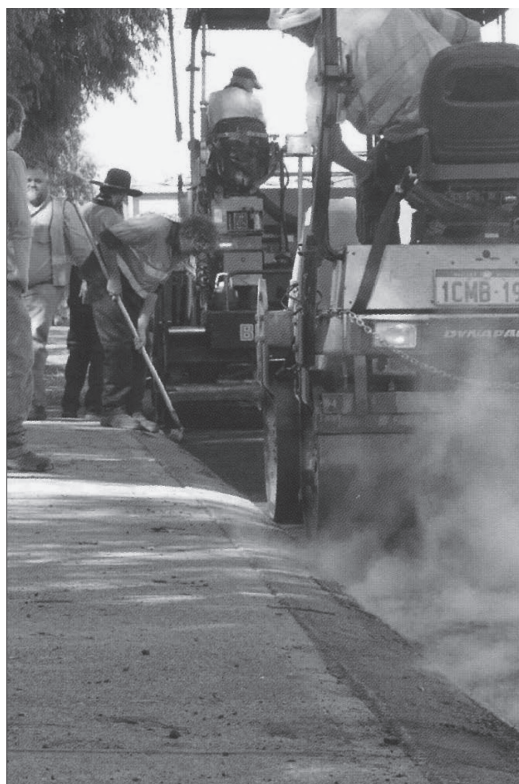
写真2 コワラマップで行われた(RCG)ガラス骨材入りアスファルト舗装で施工した施工業者マラテスタ社は“(RCG)入りの方がワーカビリティや施工性能は通常アスファルトより良い”との意見であった。
