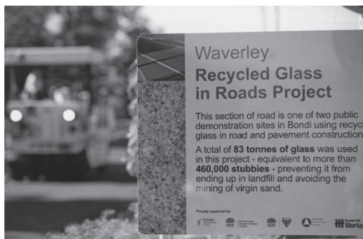
写真1 2本のボンディー道路では、83トン (460,000本のガラス瓶に相当) の破砕したリサイクルガラス (RCG) を使用して舗装施工されました。
