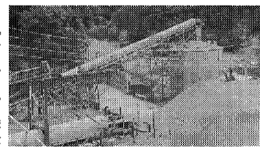
既存の合材用骨材プラント
