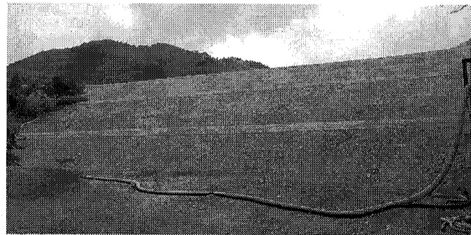
9月に完成した土留かん止堤
