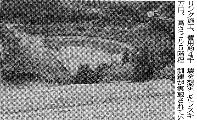
時間95分の降雨に堪える洪水調整池
