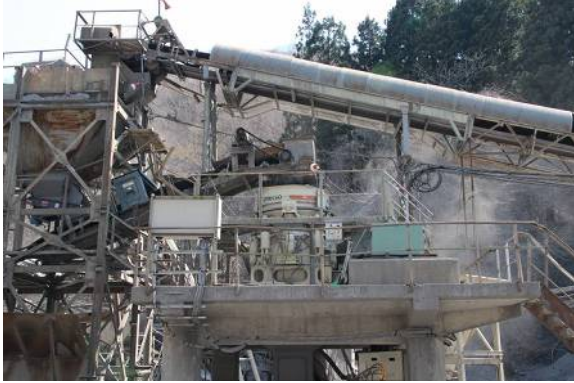
写真1 HP3 設置状況
