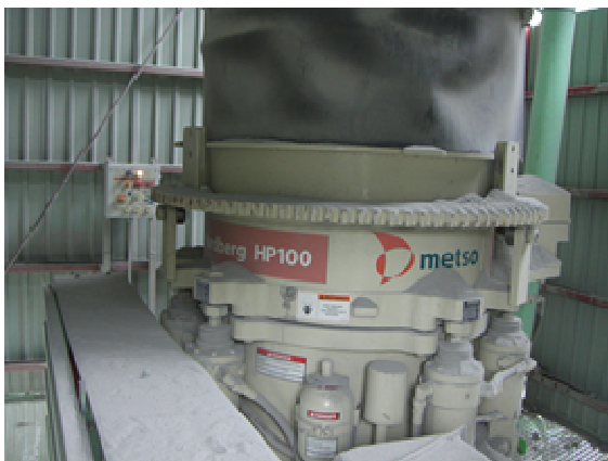
写真4 HP100設置状況
