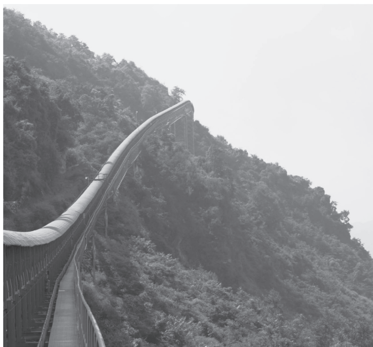
写真2 アジアセメントグループはBeumer社のベルコンシステムを信頼、採用しました
