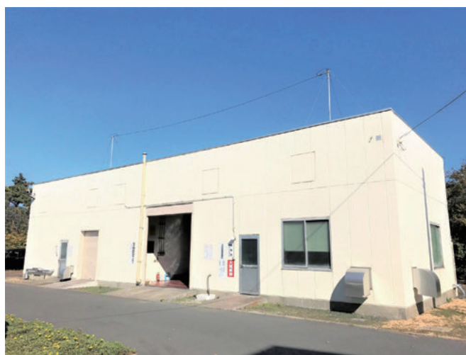
写真3 化学機器技術センター外観
