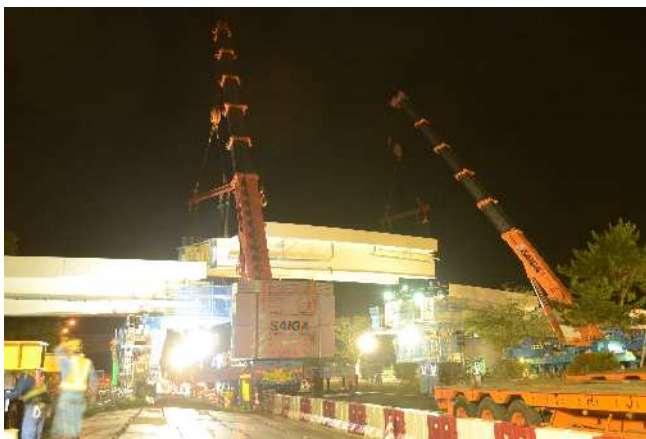
写真-1 ブロック②の相吊り架設
