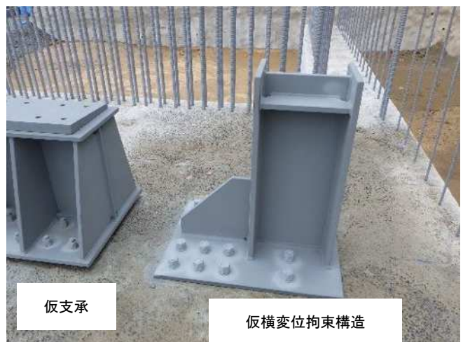
写真-4 仮支承と仮横変位拘束構造
