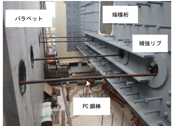
写真-2 橋台と桁の固定
