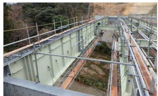
写真-1 架設状況
