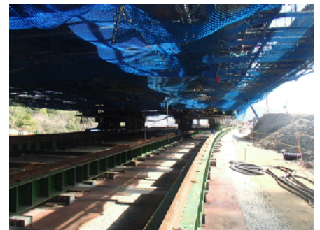
写真-1 軌条設備の設置状況
