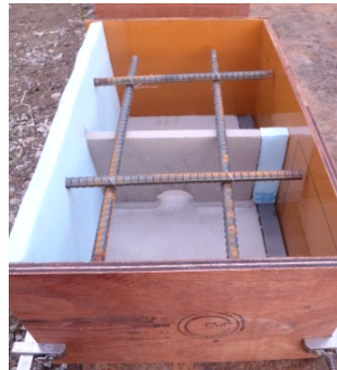
写真1 H-H-A 供試体型枠
