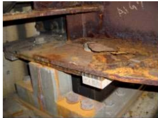
支承近傍の主桁下フランジ
