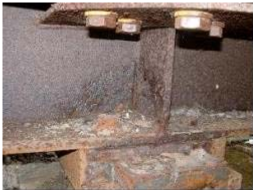
主桁下フランジと垂直補剛材
